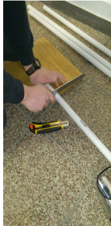
Zusägen der Rohre
